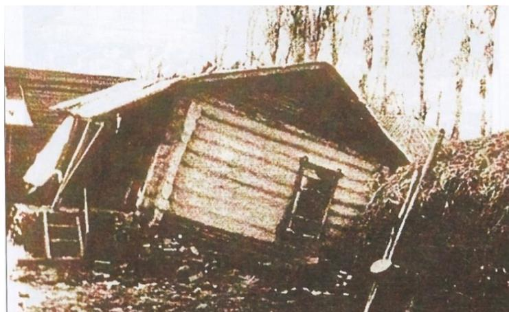
Рисунок 4 – Последствия Кеминского землетрясения на территории г. Верный (ныне Алматы). При землетрясении в грунте образовалась обширная трещина, вызвавшая разрушение фундамента здания
